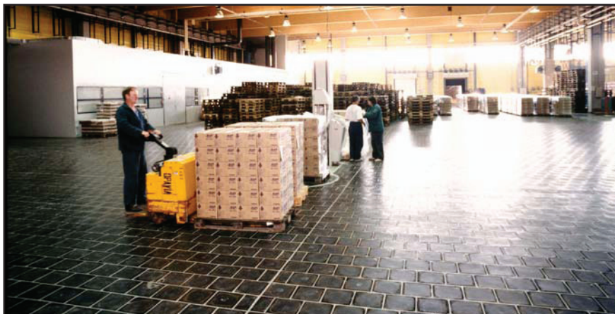
Gładka posadzka hali produkcyjnej w przemyśle spożywczym (250/250/22JR)
